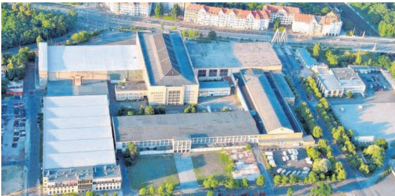
Die Ausstellungshallen 1 bis 6 werden voraussichtlich ab Sommer 2012 für ein neues Porta-Möbelhaus abgerissen. Foto: Heike Döring
