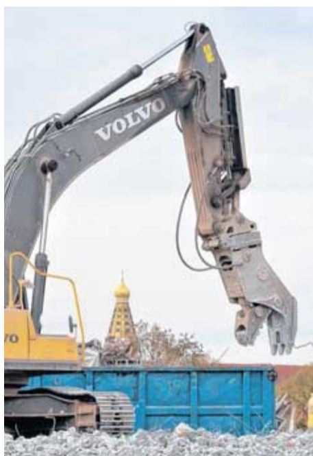
Mit insgesamt zehn Baggern rückt die Abbruchfirma den Messehallen zuleibe.
