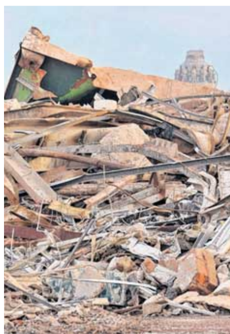
Beton, Stahl, Ziegelsteine – vieles von dem, was zu Boden geht, wird wiederverwertet.
