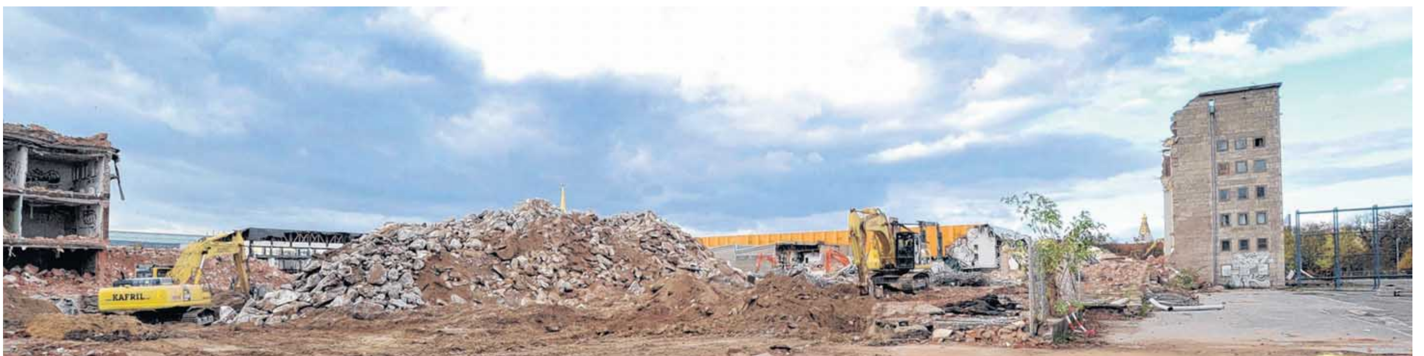
Die Alte Messe im November 2012: Von den Hallen 1 bis 6 steht so gut wie nichts mehr. Ausgenommen der Portikus der Halle 2 (rechts), der aus Gründen des Denkmalschutzes überlebt und in das Neubau-Projekt integriert wird.
